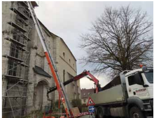
Gerüstung mit Bauaufzug zur Einbringöffnung des Dachstuhles.
