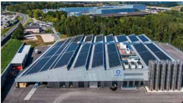
Das neu errichtete Werk 6 der AGRU Kunststofftechnik GmbH
